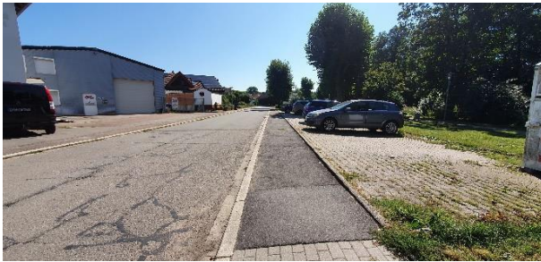
Hinterdörfer Weg (Blick von Nordwesten)
