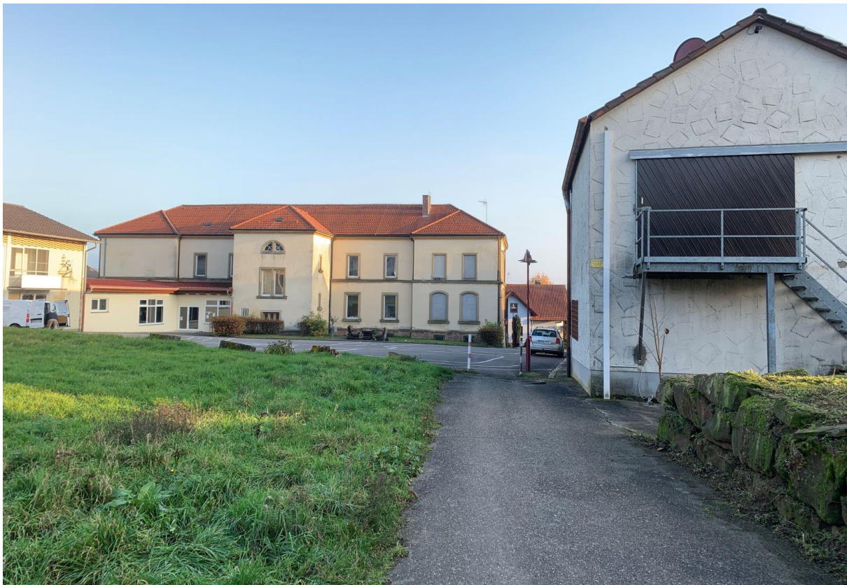
Abb. 4: Blick auf die „Alte Schule“ von Nordwesten (Wirtschaftsweg) Foto Aktiv Wohnbau GmbH, 2020.
